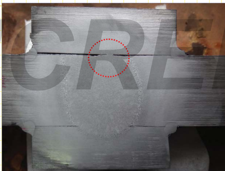
熔幅不足 巨觀圖例(熔幅小於焊接預定線)
