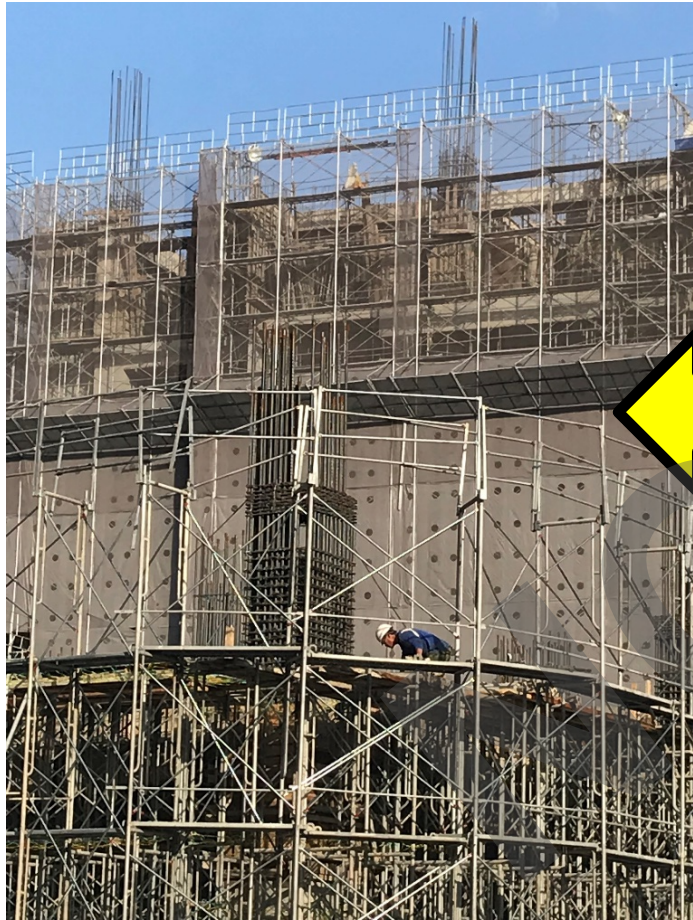
鋼筋混凝土造 (RC) 住宅
