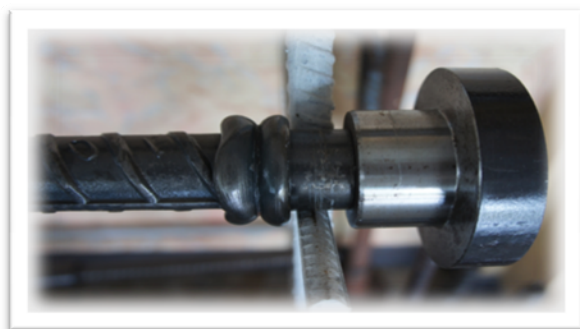
圖 7 現場量測每一根 1FL 柱鋼筋的續接高程
