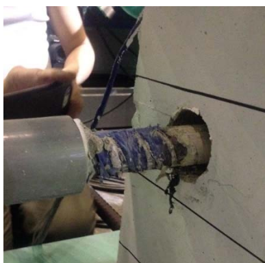
圖8 鋼筋握裹之拉拔破壞
