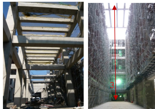
圖 5 極少支撐架的預鑄現場
