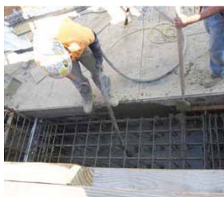
(b) 高性能纖維混凝土灌漿
