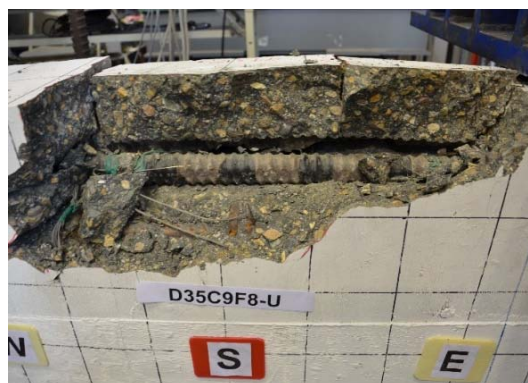
圖9 鋼筋握裹之縱向劈裂破壞
