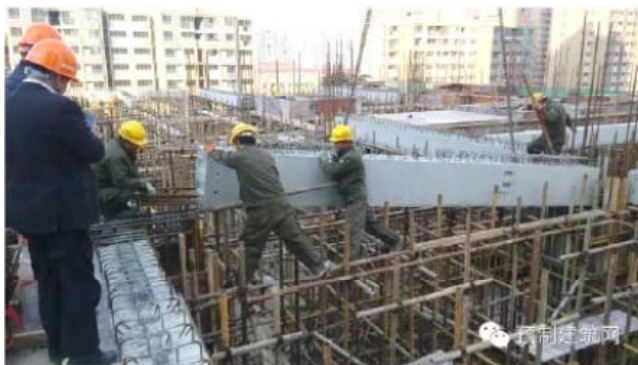
圖 4 滿堂架的施工現場
