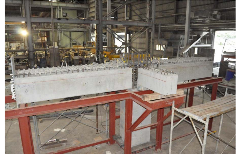
1. 梁柱構件分別鑄造完成後續接。
