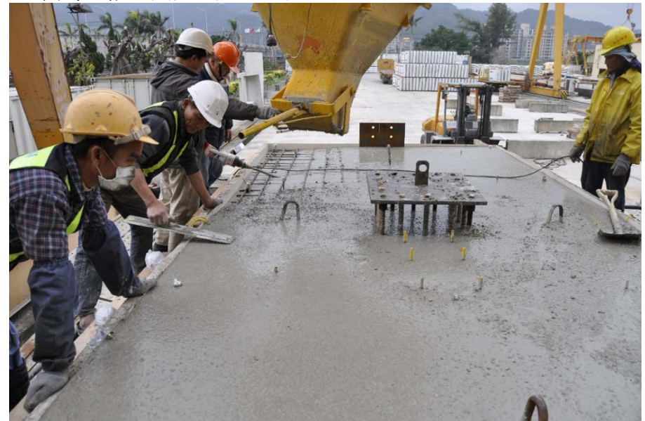
3. 樑柱接頭與版混凝土澆置。
