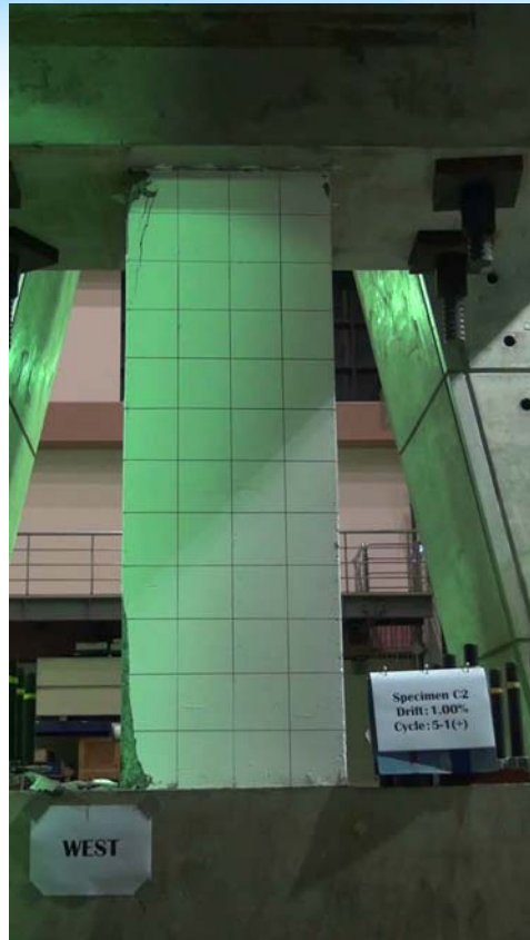
剪力鋼筋抗剪力不足以承擔混凝土開裂造成之力量重分配
