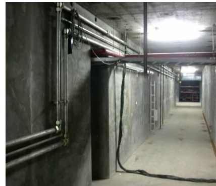
圖六 強力地板下的剪力牆
