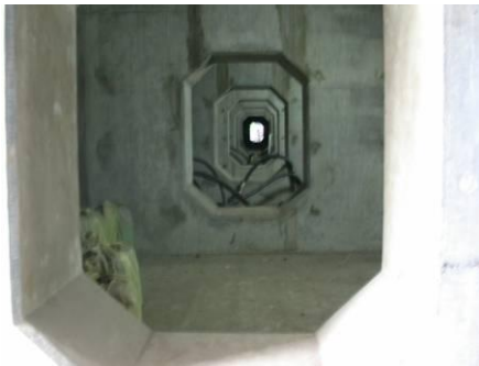
圖五 反力牆內之箱型斷面
