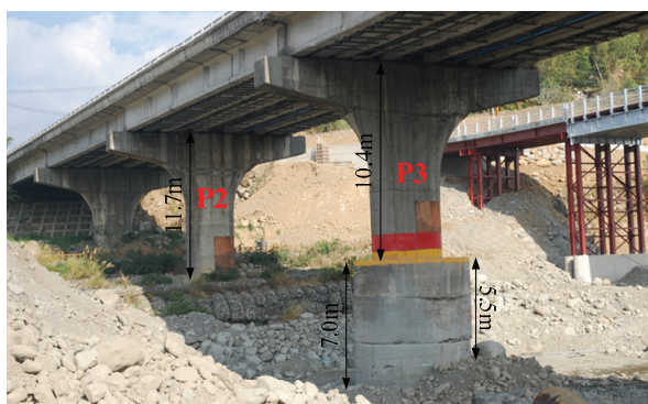
圖五 汶水橋振動量測時之橋墩裸露情況
