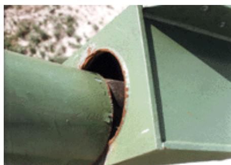
圖二 斜張橋導管破壞
