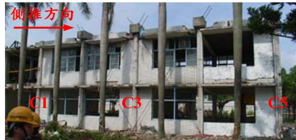
圖二 後拉式預力鋼棒補強試體
