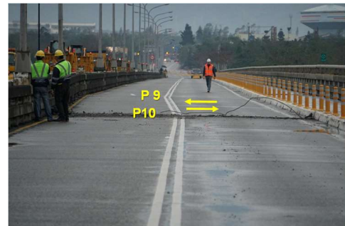
圖 9 花蓮大橋P9橋面伸縮縫損傷
