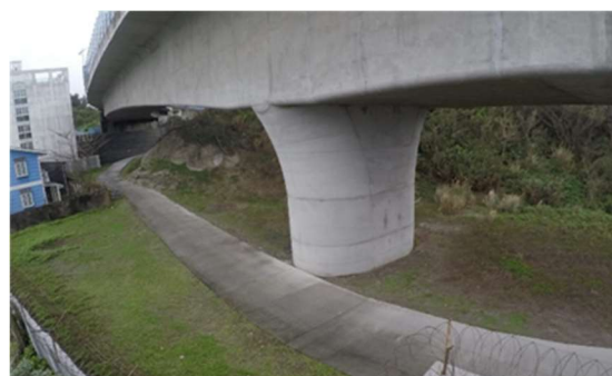
圖 20 七星潭大橋 P2 橋墩現況相片
