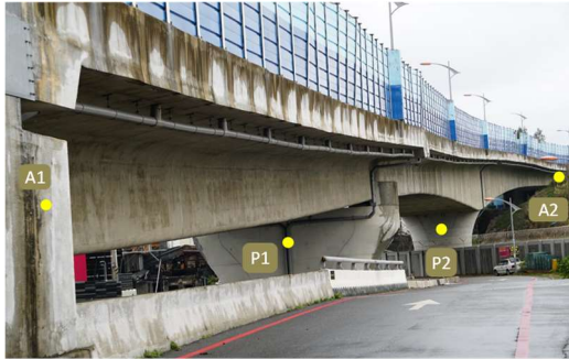
圖 15 七星潭大橋現況相片
