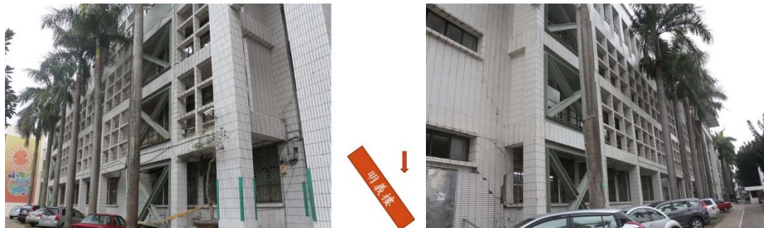
圖 19 明義樓補強位置外觀現況
