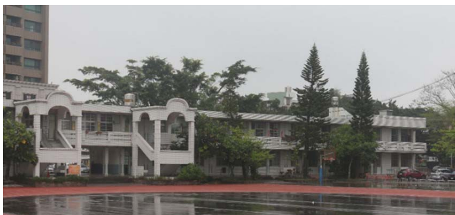
圖 12 林森樓震後外觀照片
