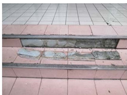
圖 13 林森樓 1F 階梯因地坪鼓起而破裂與伸縮縫裂縫
