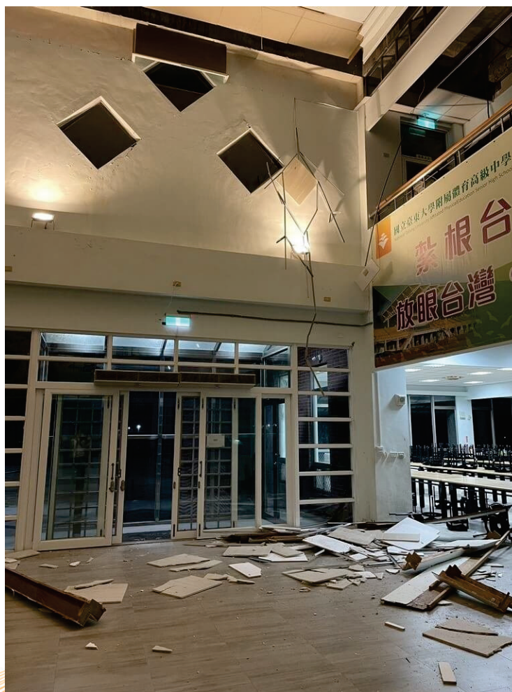
現代五項運動隊 4 樓擊劍館場館 輕鋼架天花板掉落
