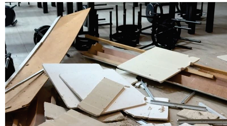
現代五項運動隊 4 樓擊劍館場館 輕鋼架天花板掉落
