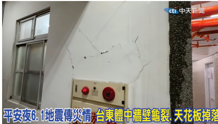
平安夜6.1地震傳災情 台東體中牆壁龜裂. 天花板掉落
