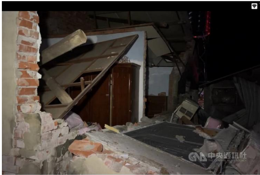
台南市楠西區一處平房住宅區21日凌晨地震後，共有約10多戶出現房屋倒塌等災損。中央社記者楊思瑞攝 114年1月21日
