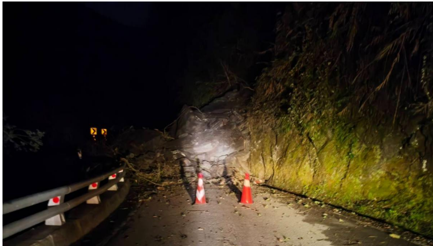
台東縣海端鄉台20線172K邊坡坍方，雙向道路阻斷無法通行。（圖／翻攝自南區養護工程分局）
