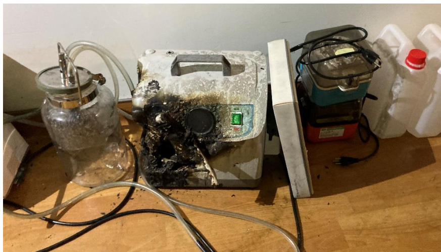
通電儀器掉落起火啟動消防撒水系統
