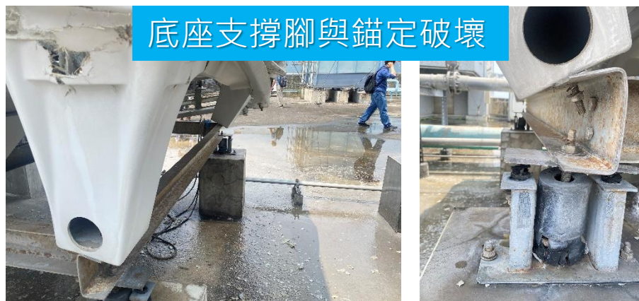
B 醫院冷卻水塔底座破壞、歪斜
