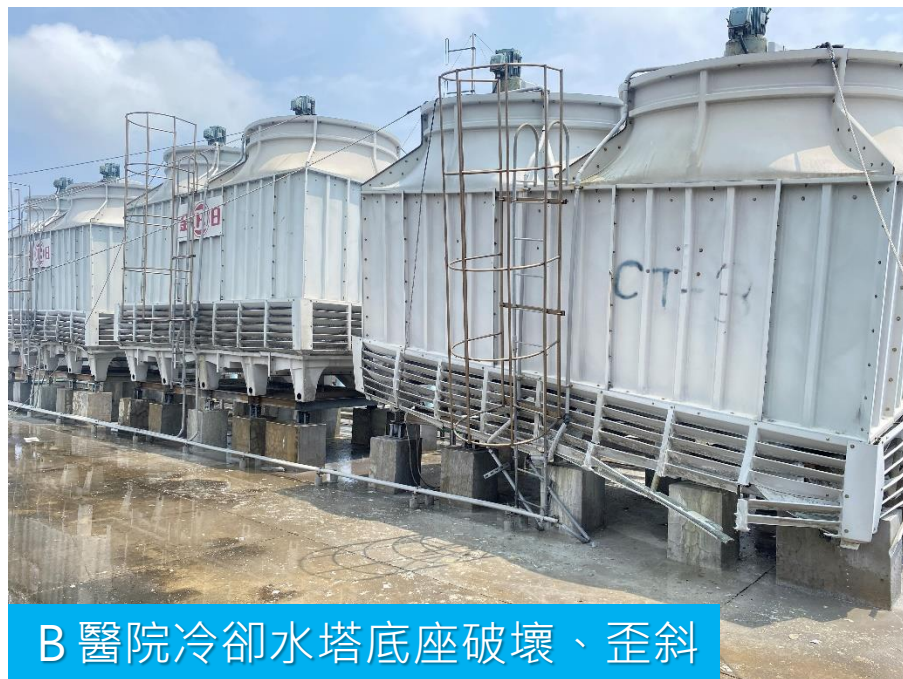
底座支撐腳與錨定破壞
