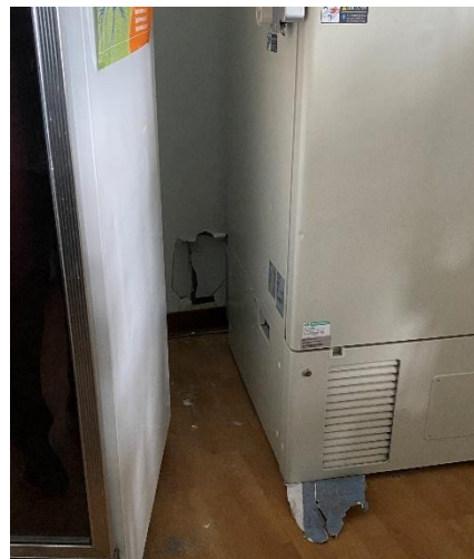
冰箱位移損及隔間牆
