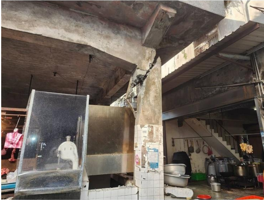
花蓮近海3日上午發生規模7.2地震，桃園大溪區三元二街一處私人市場內梁柱出現明顯裂縫且傾斜。 (大溪區公所提供) 中央社記者吳睿騏桃園傳真 113年4月3日
