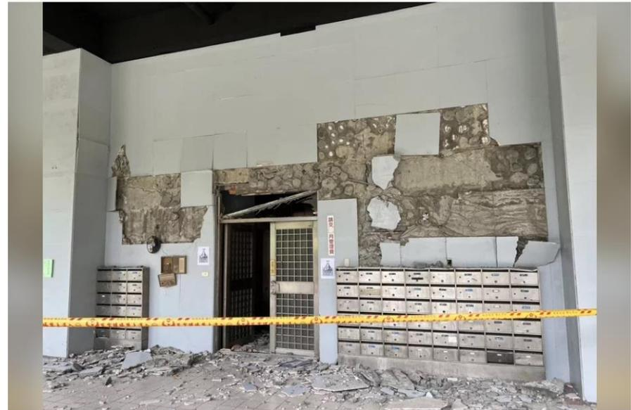
桃園市八德區「三元吉第大廈」內發生大面積磁磚脫落，只見大樓一樓入口外的牆壁磁磚掉滿地，大廈樑柱磁磚也剝落。圖／讀者提供
