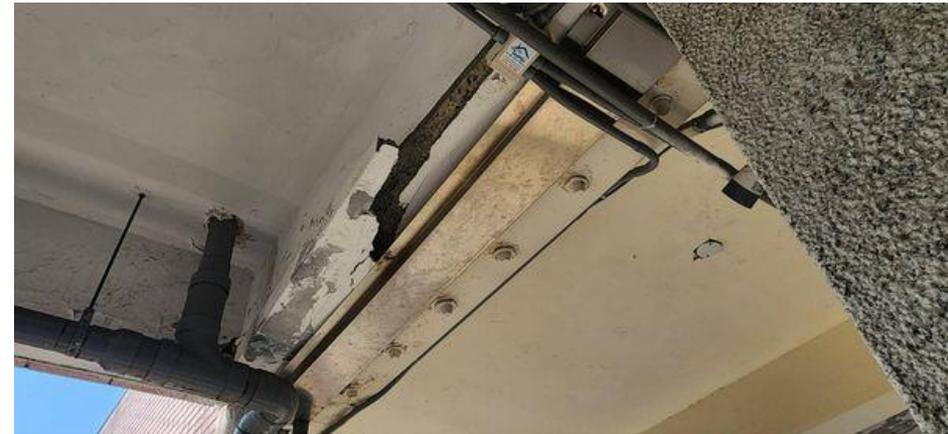
建築物碰撞，造成樓板混凝土掉落
