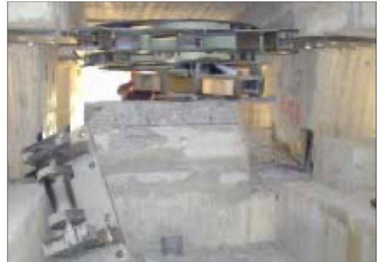
#1 高架橋 橋墩連接螺栓剪切破壞(2)
