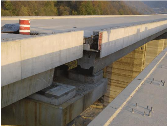
位於Kaynasl的E-5高速公路 橋墩連接螺栓剪切破壞(1)
