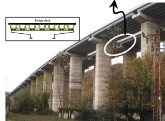
Bolu高架橋因斷層錯動產生橋墩扭轉導致上部結構破壞
