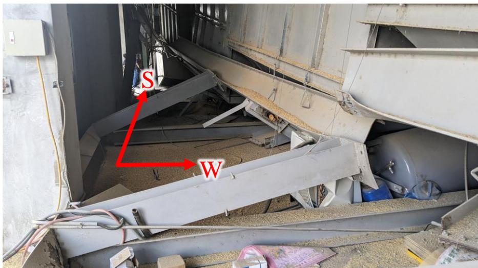
儲穀槽於9/17關山地震中，因支撐結構損壞而向西南方倒塌。
