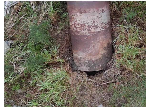
除落橋外，亦產生多處橋柱斷裂
