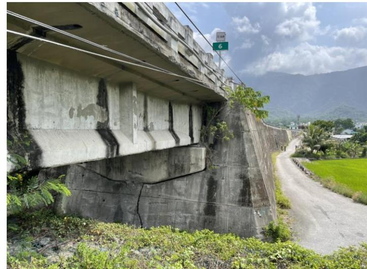
東端橋台：路面、擋土牆受損嚴重，引道嚴重下陷
