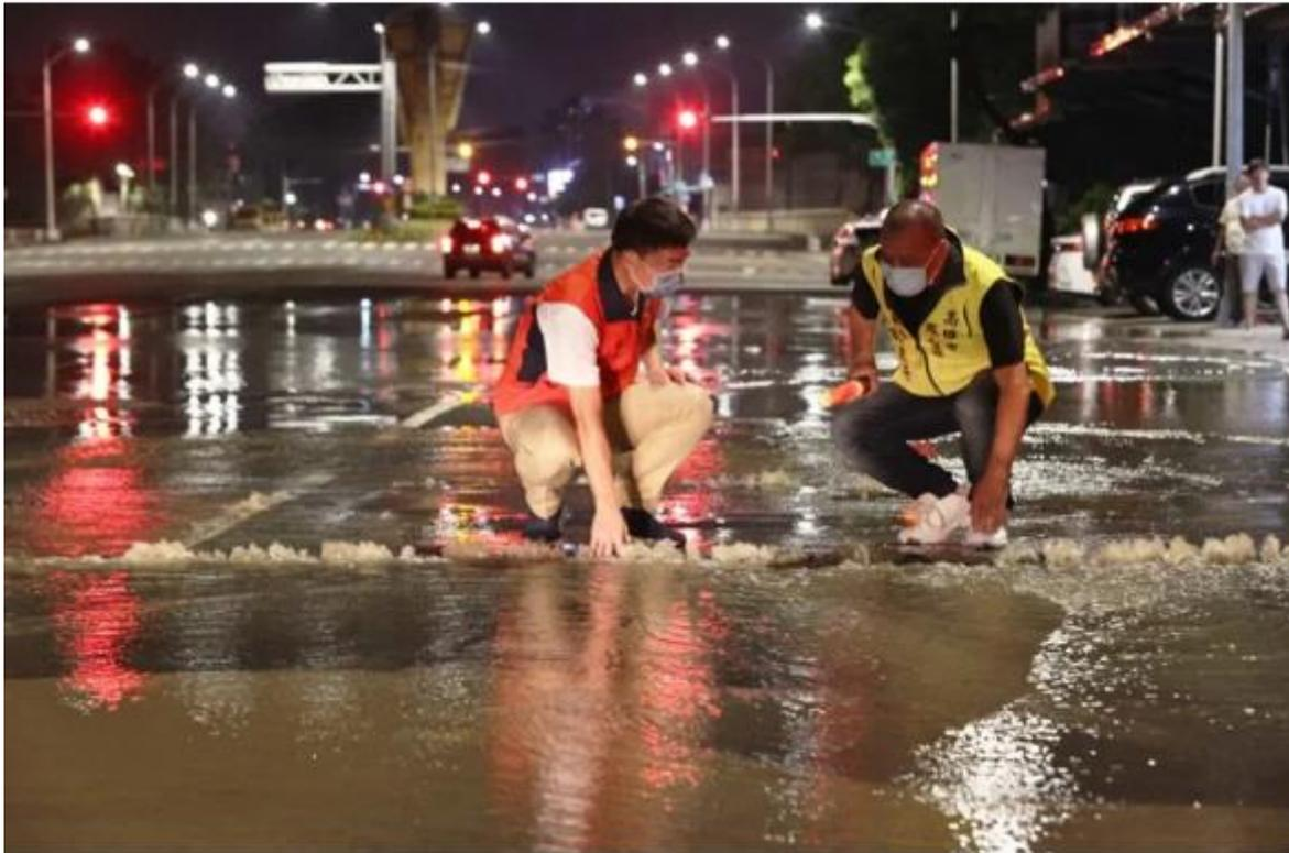
高雄鳳山凱旋路中正預校大門外有水管主幹線破裂，柏油路面裂開，大量自來水不斷湧出，當地已經停水。記者劉學聖 / 攝影
