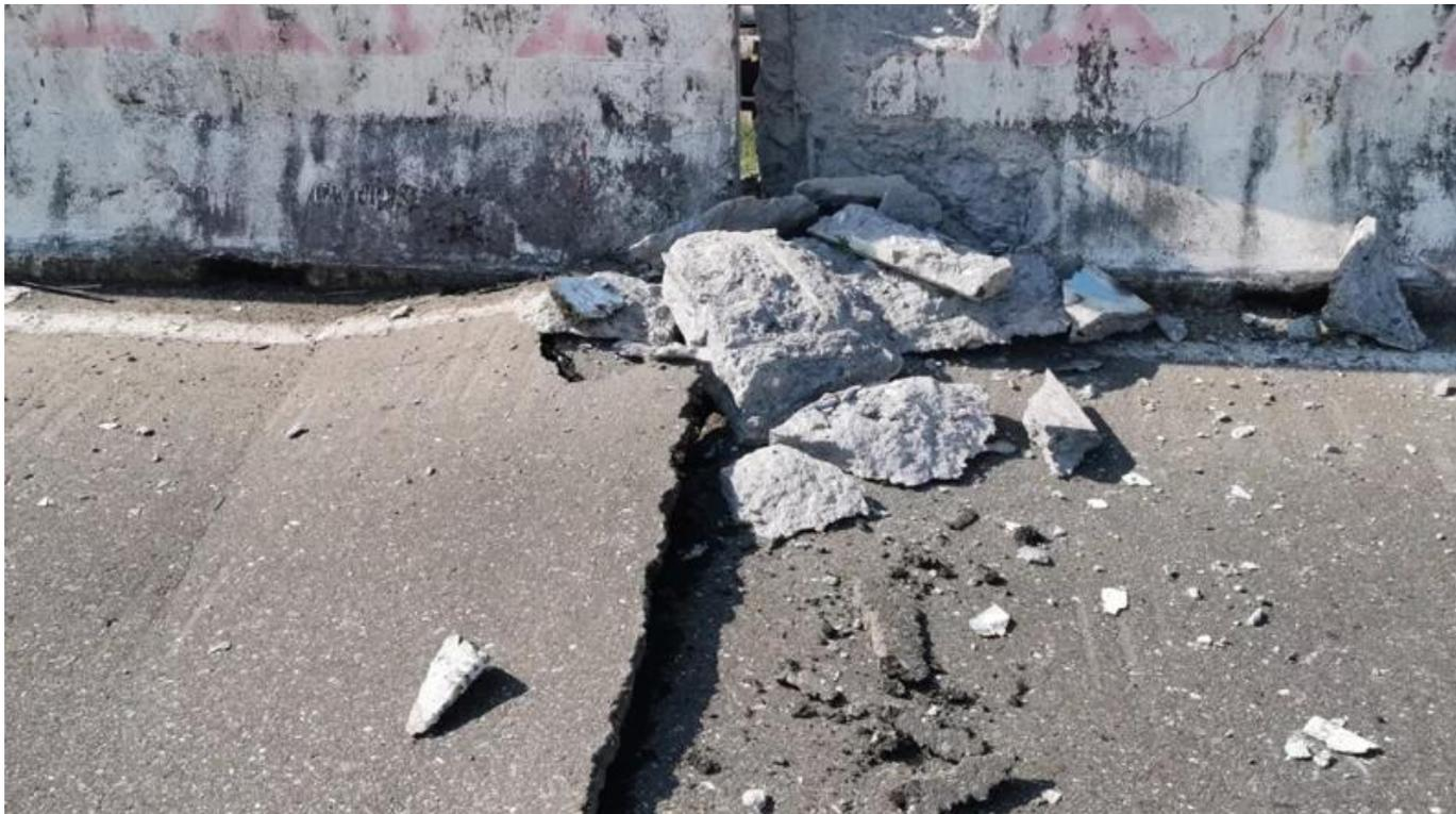
土木技師梁正儀表示，受損位置是寶華橋P3橋墩處，橋面板因為地震擠壓隆起、錯位，目測推斷大約右側20公分、左側30公分位移，後續將請橋檢單位做專業檢測，評估損害狀況。
