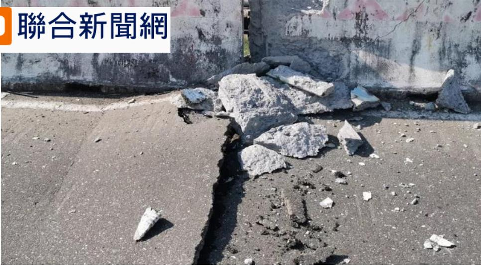
寶華大橋於民國73年興建完工，總長680公尺，幾年前曾加裝防落橋支架，避免地震震垮；昨晚地震造成「P3」橋墩處，橋面板因為地震給壓隆起、錯位，目測推斷大約右側20公分、左側30公分位移。
