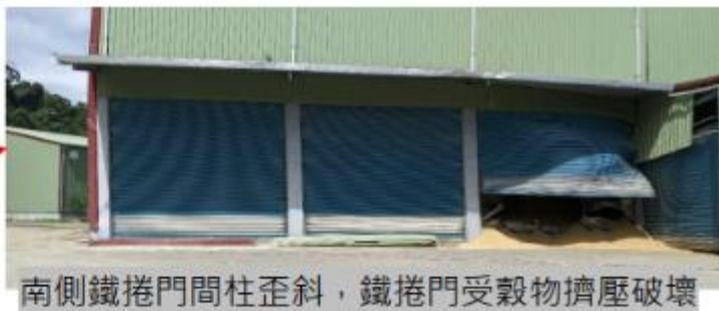
南側鐵捲門間柱歪斜，鐵捲門受穀物擠壓破壞
