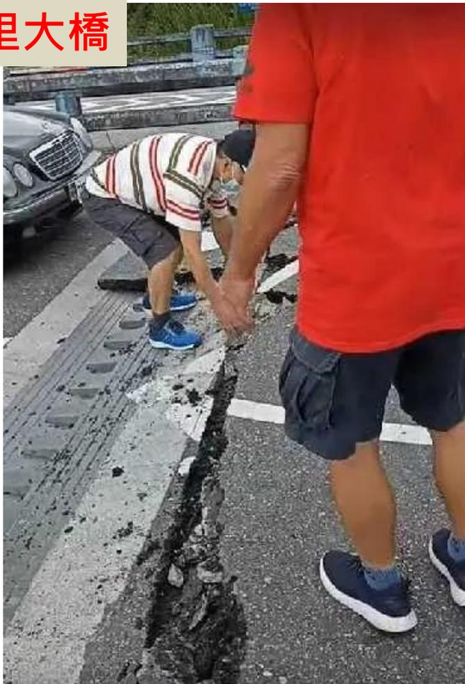
台9線、台30線共線使用的玉里大橋，南下及北上車道橋面都發生變形隆起破裂，造成車輛受阻無法通過。
