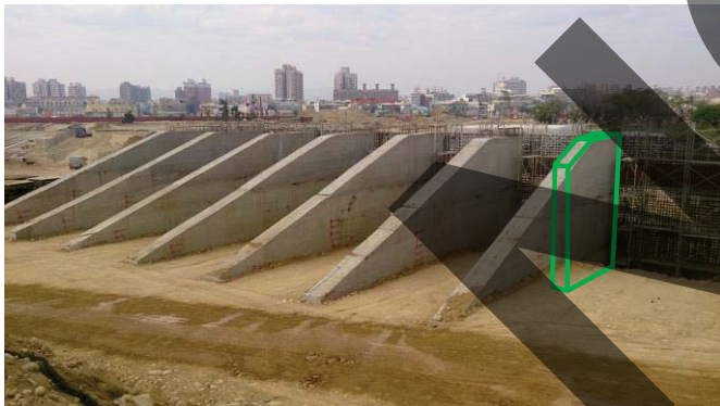
Lateral System 1 : 前側 RC反力牆
