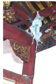
圖二十七 第二排柱頂與屋頂間結構震損 (左上：西南側外牆；右上：東北側外牆，可見屋頂梁下有明顯長裂縫與樑柱接頭破壞；左下：中廟門東北側柱頂接頭破壞、鋼筋裸露；右下：中廟門西南側柱頂接頭破壞、梁間裝飾塑像破壞掉落 (PGA: 524 gal))
