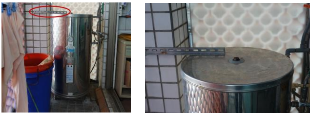
圖五十 部立臺東醫院成功分院五樓熱水器底座修復（左圖）以及頂端以角鋼支撐（右圖）情形 (PGA: 535 gal)
