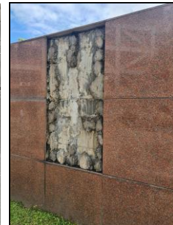
圖五十七 部立臺東醫院成功分院馬桶震損 (左) (PGA: 535 gal) 以及玉里醫院萬寧院區圍牆石材面板掉落 (右) (PGA: 218 gal)
