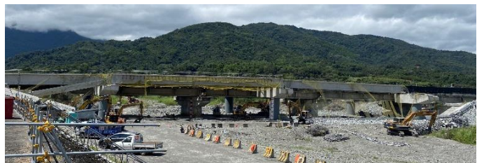
圖三十二 玉里鎮玉興橋東側拆除作業。（PGA: 135 gal）
