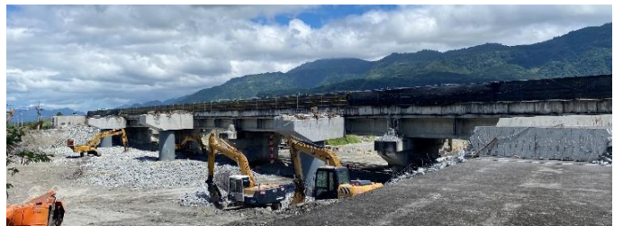
圖三十三 玉里鎮玉興橋西側拆除作業。（PGA: 135 gal）
