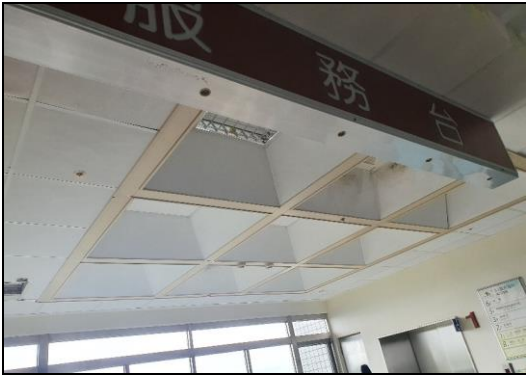
圖三十八 一樓梯廳處之造型天花板。(PGA: 535 gal)
