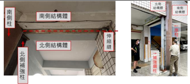
圖十九 成功國小西棟大樓南北側之間伸縮縫以及補強鋼柱與原柱螺栓相接 (PGA: 515 gal)
