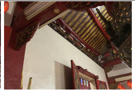
圖二十六 福德宮廟門上方橫梁至屋頂脊梁間並未相連，而以混凝土鑄造之塑像夾持於兩梁之間，形成勁度不連續之結構弱點 (PGA: 524 gal)
