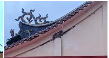
圖二十六 福德宮廟門上方橫梁至屋頂脊梁間並未相連，而以混凝土鑄造之塑像夾持於兩梁之間，形成勁度不連續之結構弱點 (PGA: 524 gal)
