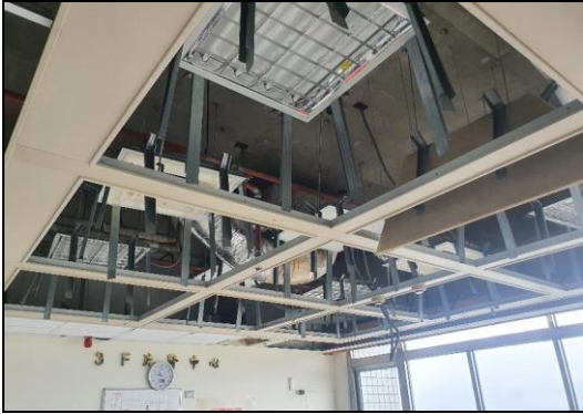
圖三十九 三樓梯廳處之造型天花板。(PGA: 535 gal)
