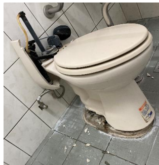
圖五十七 部立臺東醫院成功分院馬桶震損 (左) (PGA: 535 gal) 以及玉里醫院萬寧院區圍牆石材面板掉落 (右) (PGA: 218 gal)
