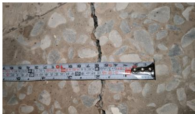
(a) 地板裂縫寬度
