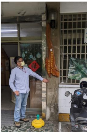
(a) 入口處北側 RC 柱
