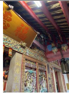
圖二十六 福德宮廟門上方橫梁至屋頂脊梁間並未相連，而以混凝土鑄造之塑像夾持於兩梁之間，形成勁度不連續之結構弱點 (PGA: 524 gal)
