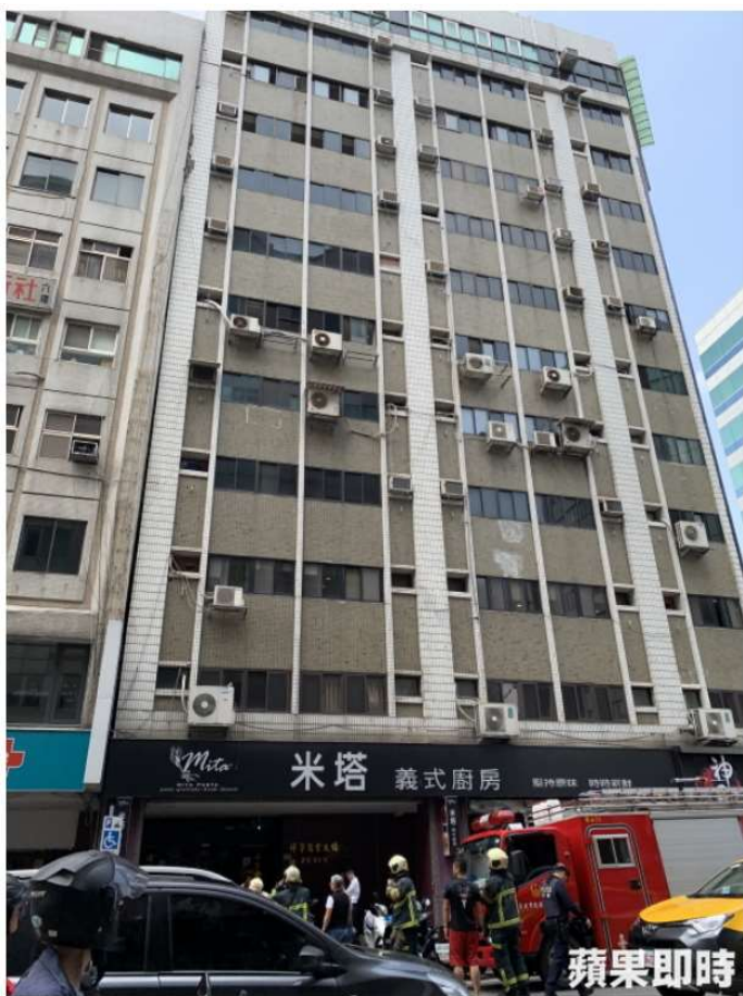
北市長安東路77號大樓傾斜靠在81號大樓。塗豐駿攝
