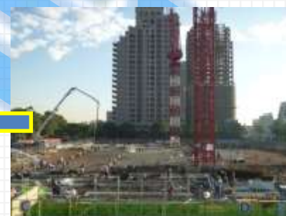
101/12/28 1F鋼筋綁紮、澆置
