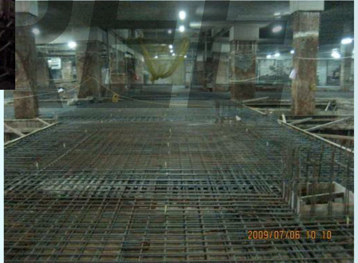
綁紮筏基上版鋼筋
