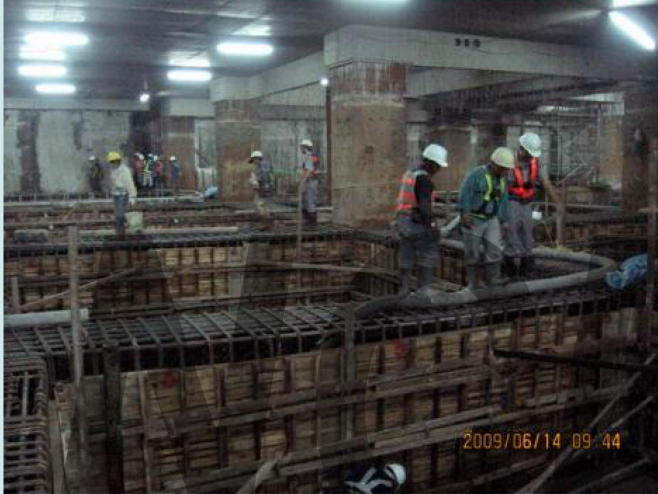
基礎梁混凝土澆灌
