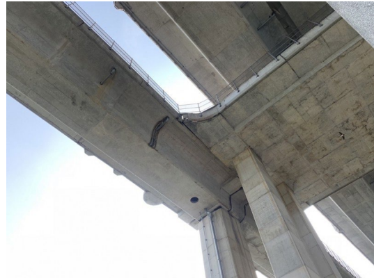
(2) 橋下遠觀混凝土護欄接縫
