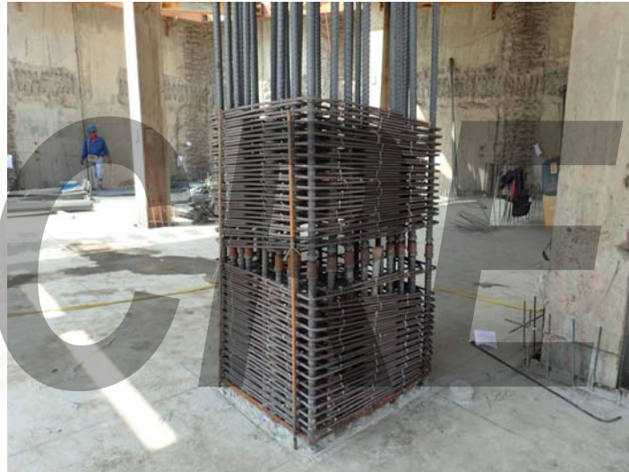
系統柱箍精準定位
