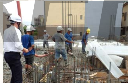
建築安全履歷協會 - 混凝土澆置施工察證
