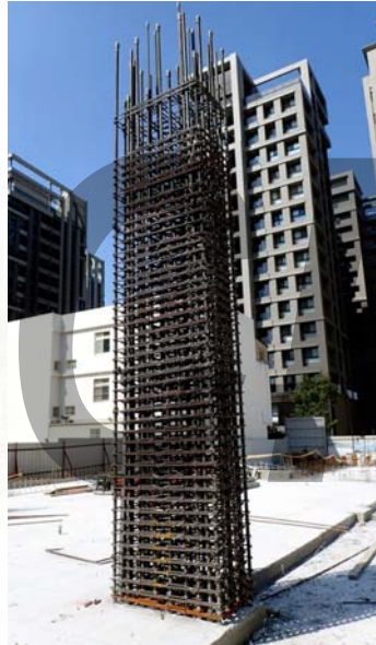
Alfa Safe耐震系統工法柱完成圖
