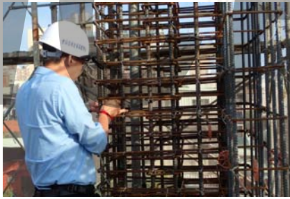
建築安全履歷協會 - 柱鋼筋施工察證
