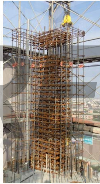
Alfa Safe耐震系統工法柱完成圖
