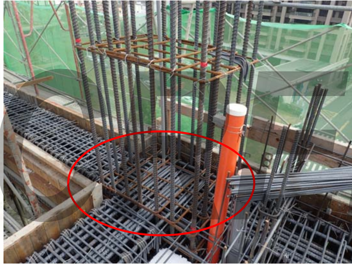
系統柱箍精準定位
