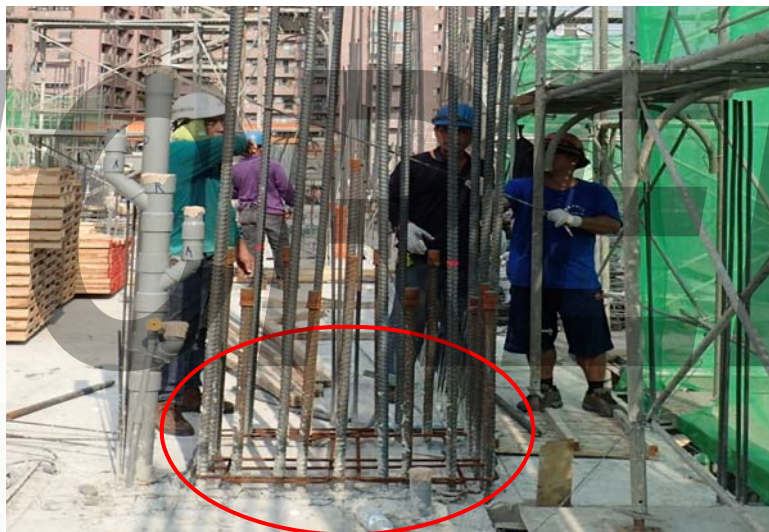
系統柱箍精準定位
