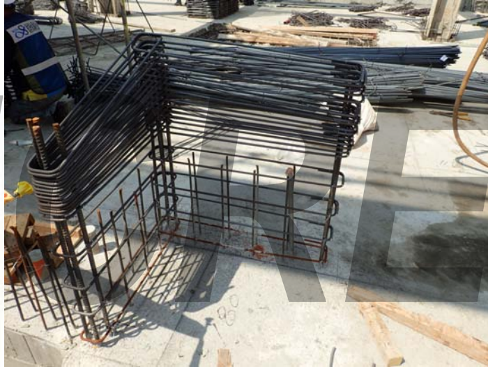
L型系統牆箍精準定位
