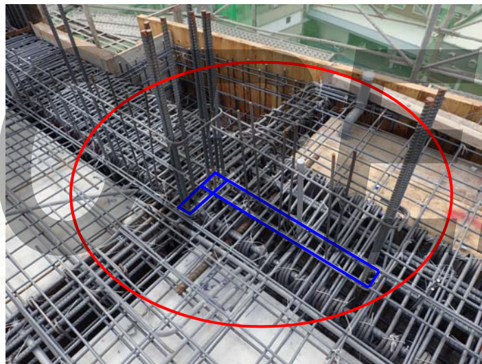
L型系統牆箍精準定位
