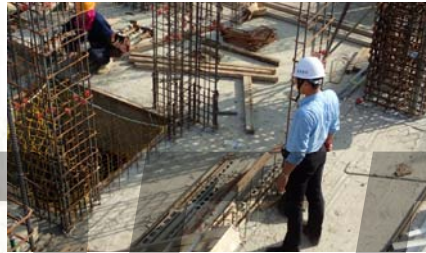
建築安全履歷協會 - 牆鋼筋施工察證
