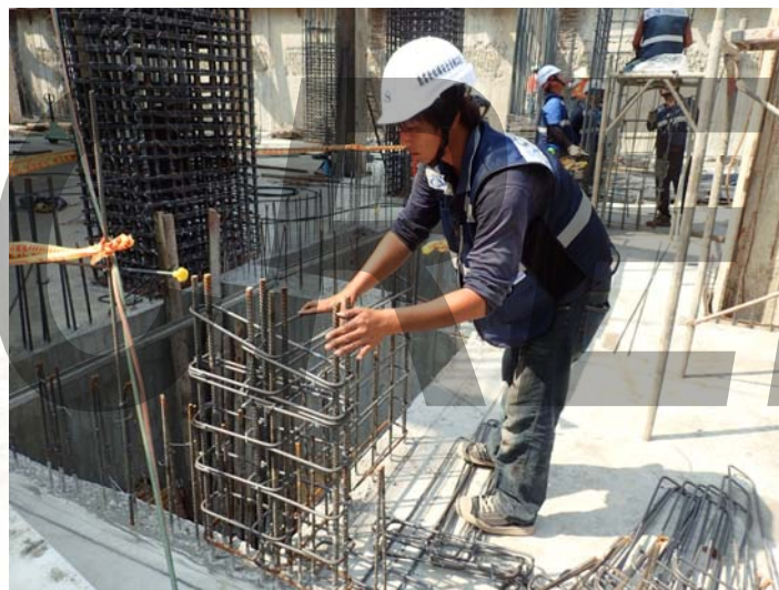
L型系統牆箍精準定位
