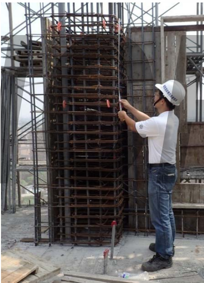
結構安全查驗 – 鋼筋查驗
