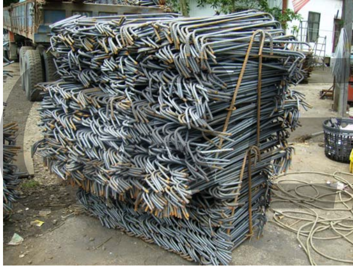
鋼筋施工品質不良之問題 – 傳統工法組件繁複施工不易
