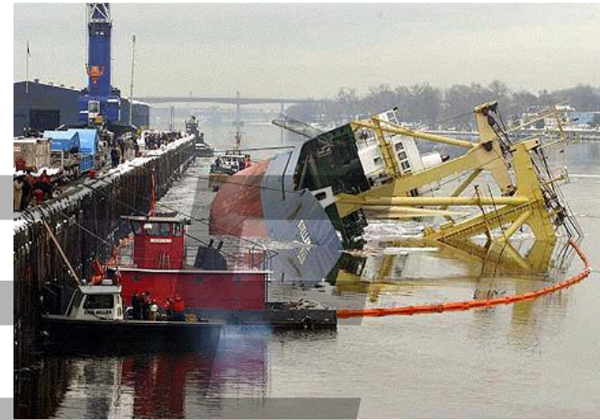
吊裝穩度不足
