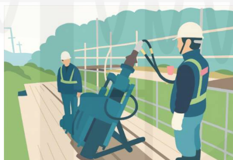
圖五 路堤邊坡架設鷹架作業平台與鑽孔機具示意
