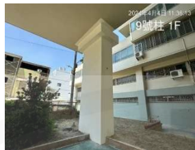
屏東案例 A01400 (補強後)
