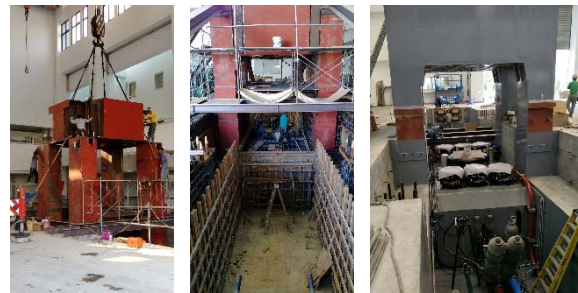
圖十一 BATS 施工照
