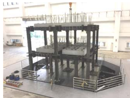
圖一 兩層兩跨空構架試體組立完成
