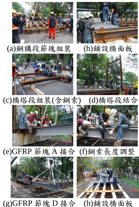
圖 6 輕便橋現地組裝與渡河實驗之照片
