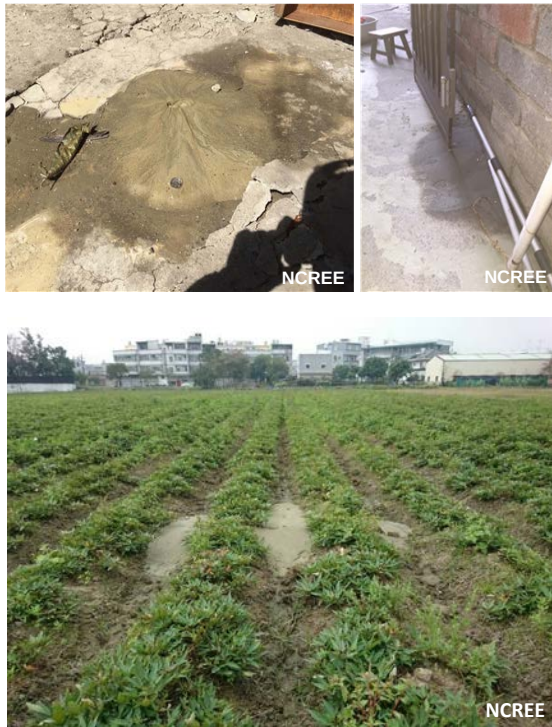
圖 2 台南市因土壤液化產生之噴砂[2]
