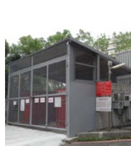
圖11 戶外-鋼瓶框架需固定
