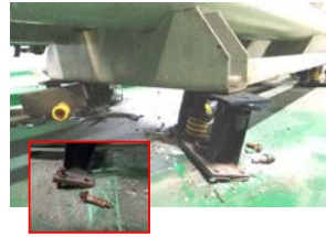
圖6 冰水主機彈簧隔振器破壞
