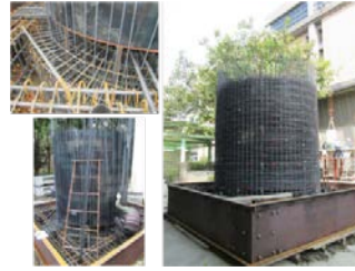
圖六 試體壁體施工圖
