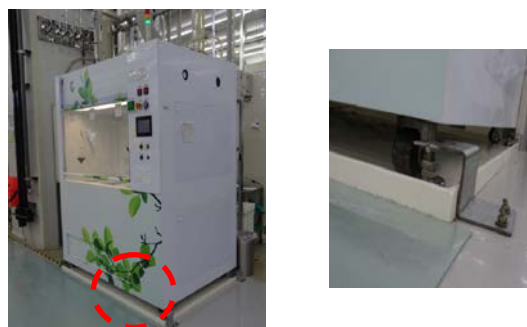
圖4 一般設備物底部有防漏盤之補強
