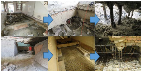
圖 9 千斤頂頂升工法施工流程照
