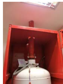
圖10 自動滅火系統鋼瓶位移
