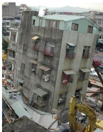
圖一 公寓塌陷
