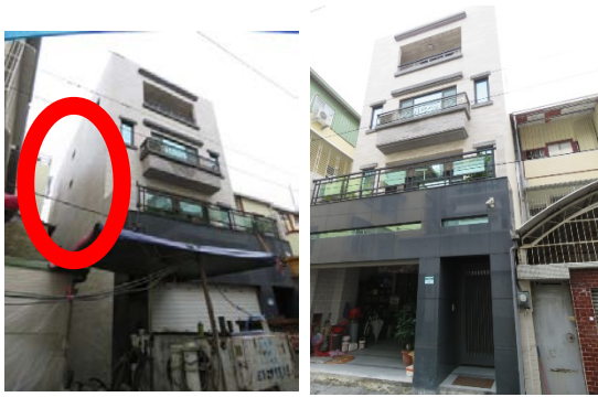
圖 8 安南區府安路街屋復舊狀態
