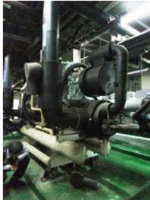
圖6 冰水主機彈簧隔振器破壞
