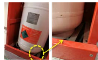
圖10 自動滅火系統鋼瓶位移
