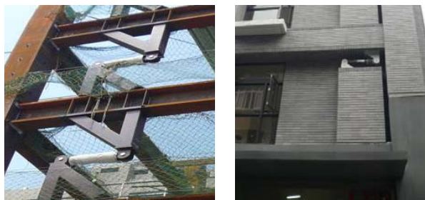
圖三 國內現行常見之斜撐型式阻尼器系統實際案例
