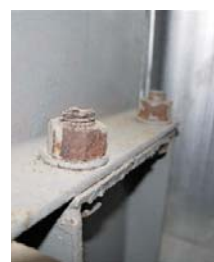
圖三 鏽蝕程度(少許生鏽)
