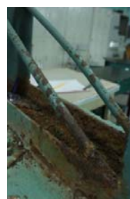
圖四 鏽蝕程度(嚴重生鏽)
