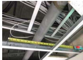
圖8 懸吊線吊點間距
