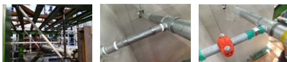
(b) 斜撐 (c) 可撓性軟管 (d) 機械接頭
