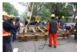
(a) 鋼構段節塊組裝
