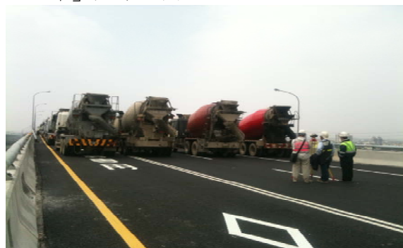
圖3 五楊高架橋載重試驗與水準測量
