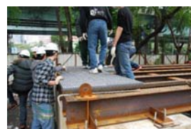
(b) 鋪設橋面板
