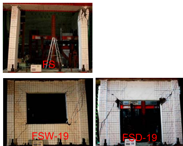
圖四 試體主要破壞情形
