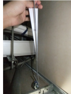
圖11 懸吊線傾斜度
