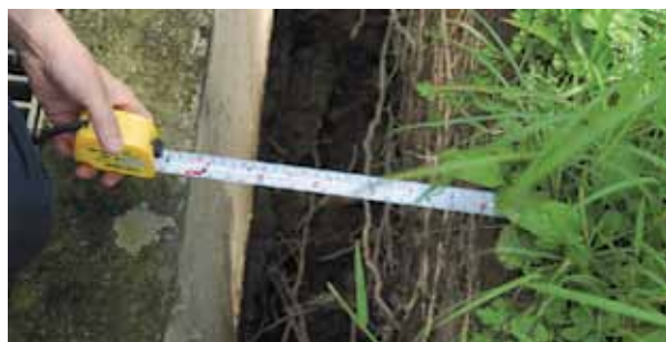
圖五 擋土牆頂外移量之直接量測情況
