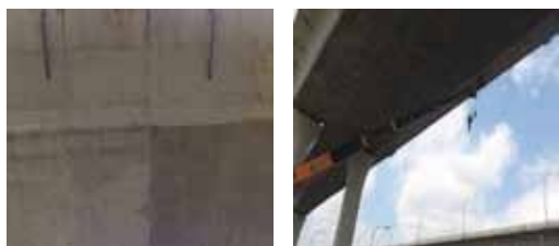
圖一 現地全橋與補強照片檢測
