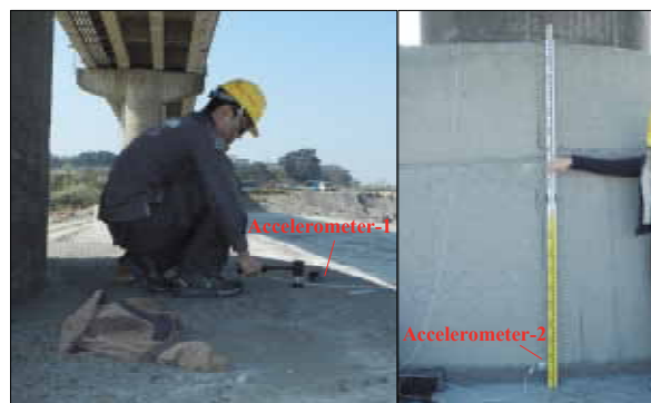
圖六 舊中正橋 P11 衝擊反應檢測情況
