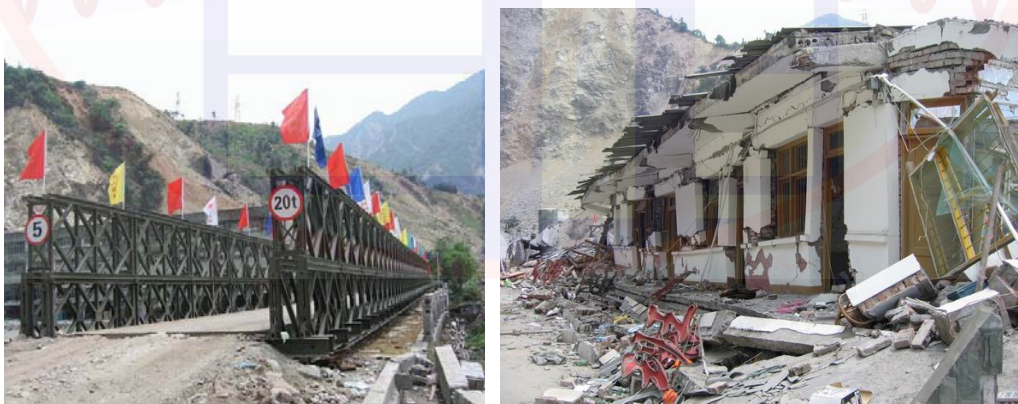
圖二十九：通往映秀鎮內之臨時搭建橋梁，以及橋頭旁損毀之道路班廳舍
