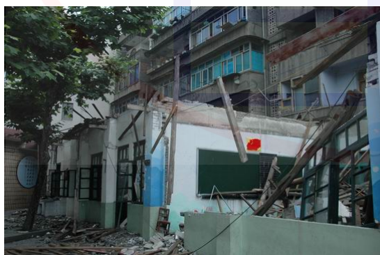
圖四：都江堰市新建小學震毀之校舍結構
