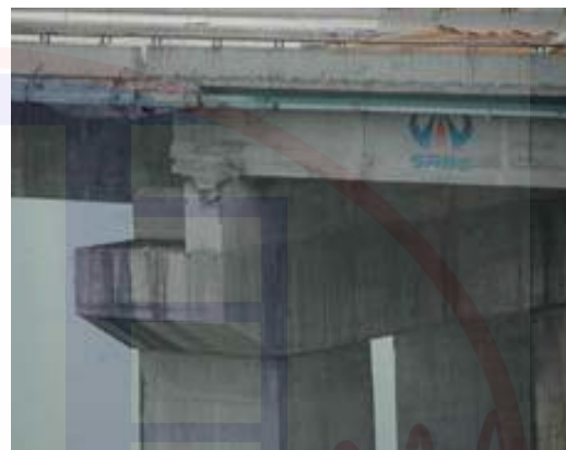
圖十九：成汶高速公路橫跨岷江之大橋(施工中)震損情形
