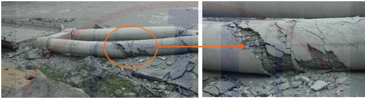
圖二十四：由爆破後百花大橋之橋柱主筋與箍筋可知其橋柱應為韌性設計
