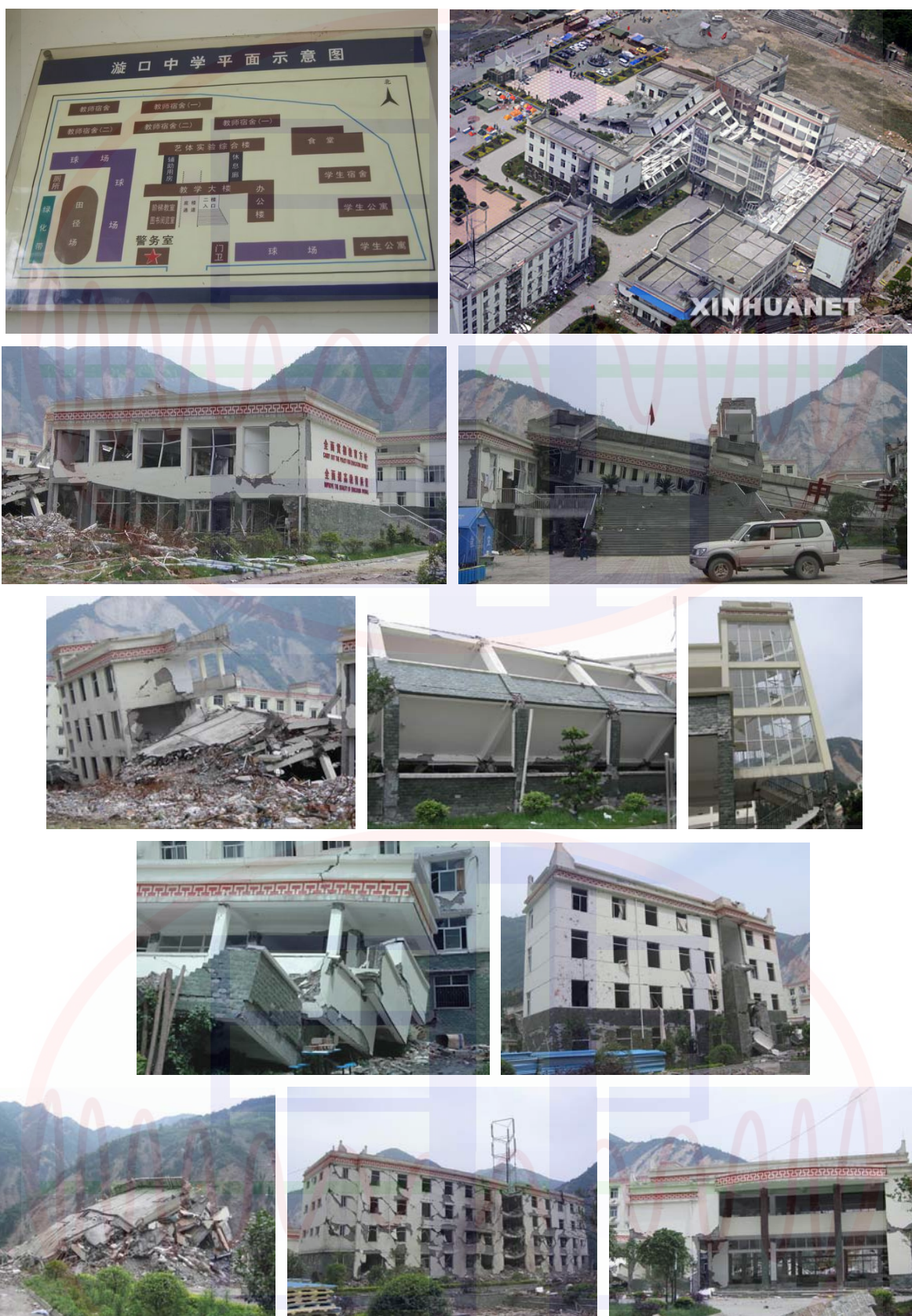
圖二十七：映秀鎮漩口中學各棟校舍之倒塌損毀情形(右上角之空拍照取自新華網)
