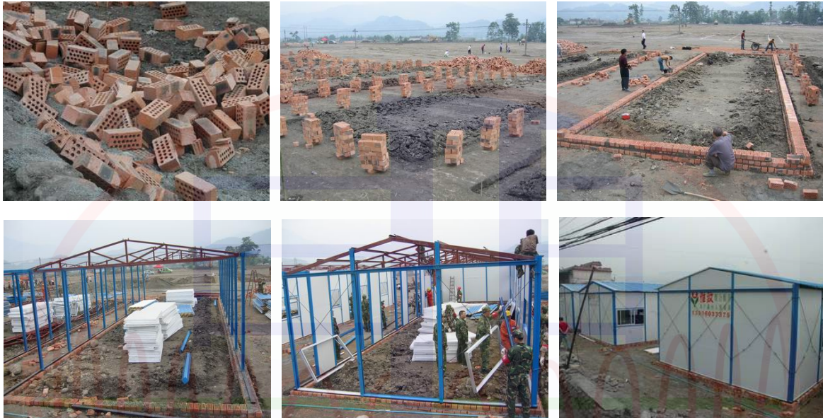
圖十四：過渡安置用活動板屋之組合過程
