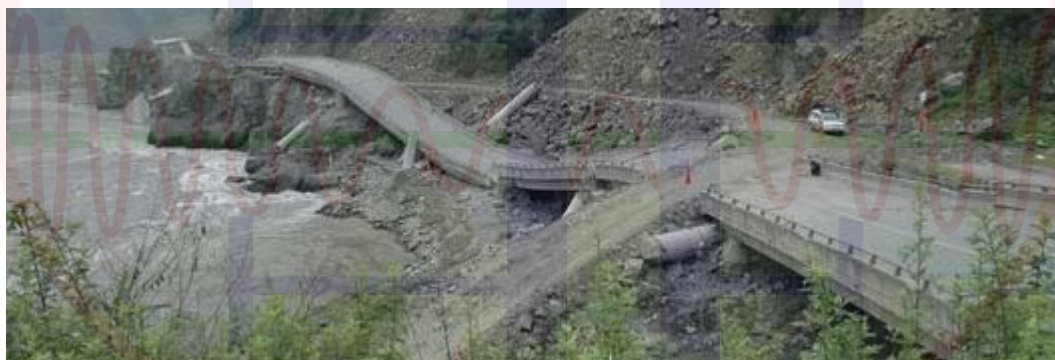
圖二十三：國道 213 線之百花大橋於地震時發生落橋嚴重損傷，殘餘之橋體已於 5 月 28 日爆破拆除(空拍照分別取自新華網與華西都市報)
