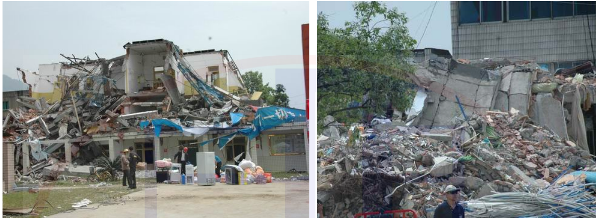
圖十二：漢旺鎮綿竹第三醫院因建物倒塌而喪失其醫療功能
