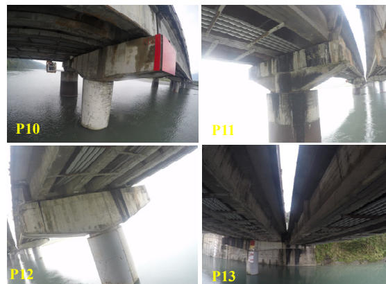
圖十七 花蓮大橋P10-P13橋墩
