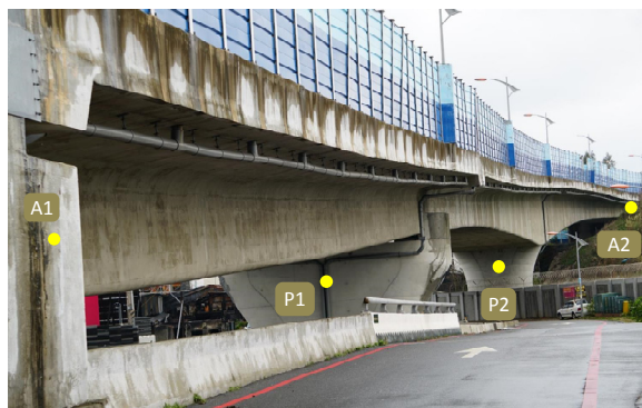
圖十九 七星潭大橋現況相片
