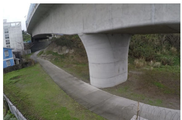
圖二十五 七星潭大橋P2橋墩現況相片
