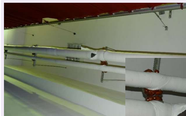
活動中心冰水管破裂
