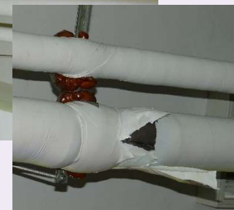
活動中心冰水管破裂
