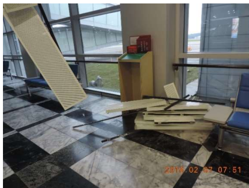
金屬沖孔明架天花板+塑膠板明架天花板
