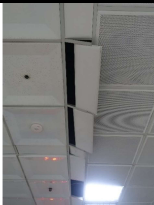
金屬沖孔明架天花板+塑膠板明架天花板
