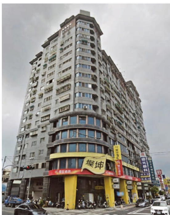
(A) 倒塌前 (取自 Google 地圖)
