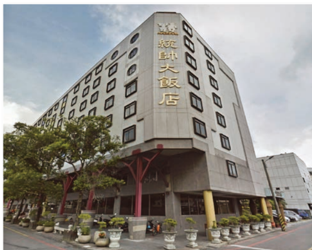
(A) 倒塌前 (取自 Google 地圖)
