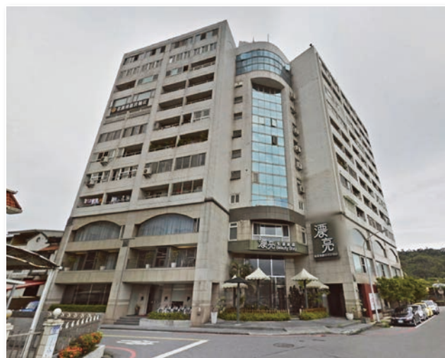
(A) 倒塌前 (取自 Google 地圖)
