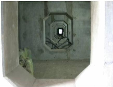
圖五 反力牆內之箱型斷面
