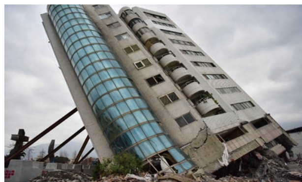
圖 3 2018 年花蓮地震之樓房崩塌
